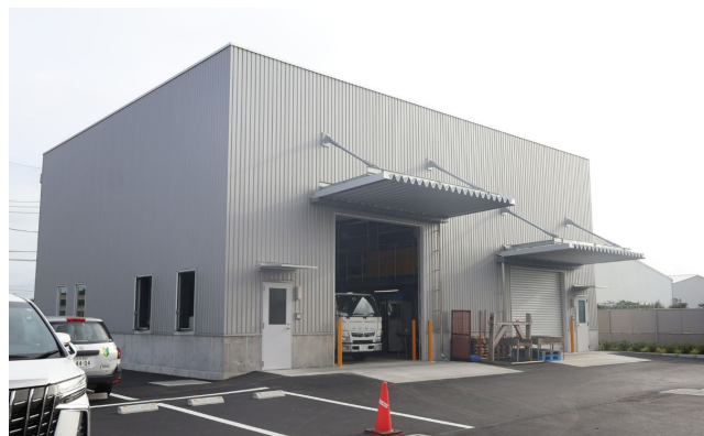
回転機整備棟
