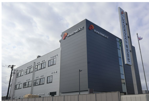
鹿島事業所新事務所棟
