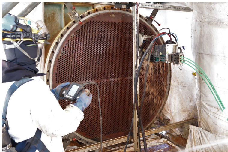
自動内面洗浄機による洗浄の様子
