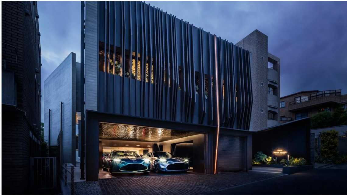
N°001 Minami Aoyama Designed by Aston Martin（2025 年 6 月竣工）
