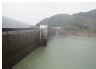
事前放流後の貯水池（草木ダム）
