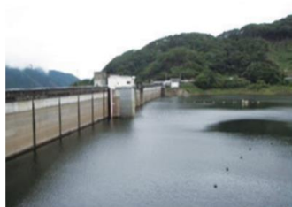
洪水前の貯水池（草木ダム）
