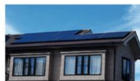
太陽光発電システム
