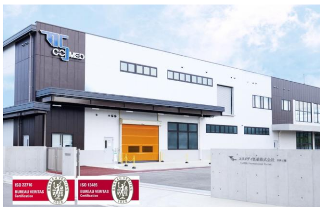
マイクロニードル製品マザー工場「吉祥工場」
