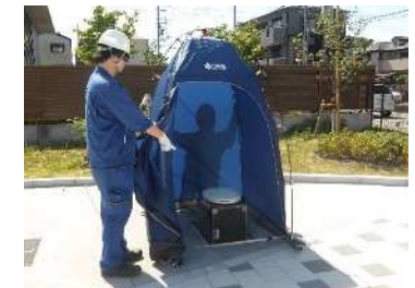
④マンホールトイレ
