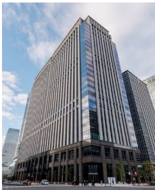
本館（呉服橋方面より撮影）
