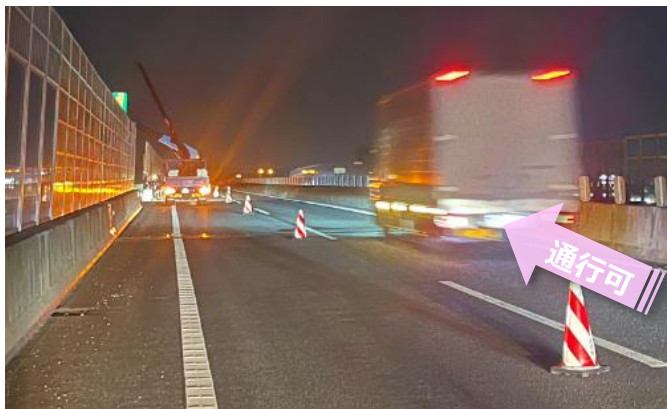
【写真】久喜白岡JCT～幸手IC 車線規制状況
