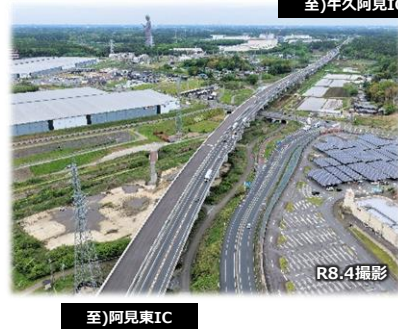
【牛久阿見IC～阿見東IC間】写真③ ※舗装工事 施工中
