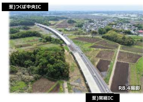
【常総IC～つくば中央IC間】写真② ※舗装工事 施工中
