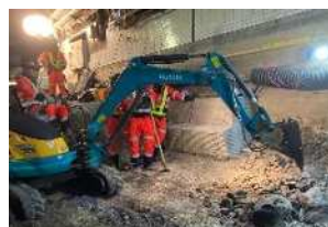
インバート掘削状況
