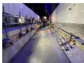
コンクリート打設完了状況
