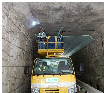
写真-3 打音による点検状況 (左:トンネル内、右:ボックスカルバート内)
