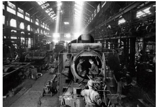
④大宮工場で機関車を修理する国鉄職員 (1945年9月)
