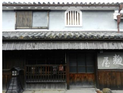
本瓦葺きの屋根と虫籠窓、幕板、手摺状の格子などが特徴的な町家
