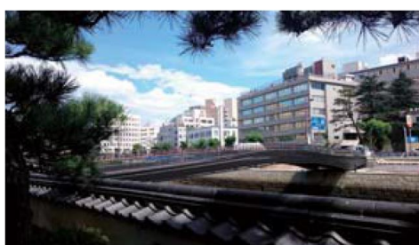
2017年11月25日開通予定の出島表門橋
