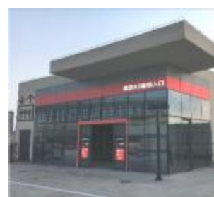
屋上の館内入口
