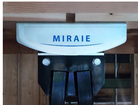
高減衰ゴムが設置されたダンパー部分 ※4
