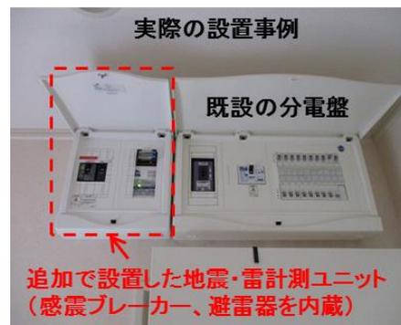
本プロジェクトは、住宅用分電盤の中に組み込む感震ブレーカー及び避雷器にセンサーを取り付け、あらゆるモノがネットにつながる IoT 技術を使って地震と雷のデータをクラウドで蓄積・分析することにより、居住者に被害状況をメール通知したり、多数の住宅から集めたビッグデータを防災に活用するシステムを実証するものです。首都圏の住宅 100 軒程度に設置工事を進めており、データの取得を開始しています。
