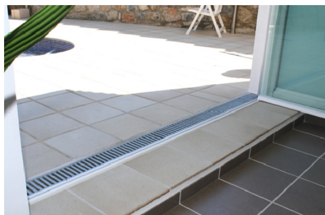
下レール埋め込み
