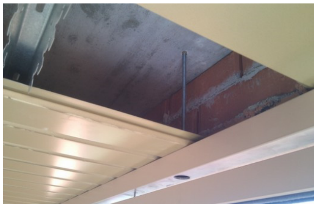
吊り天井への設置
