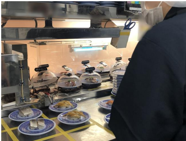
厨房側に設置された「紫外線殺菌システム」
