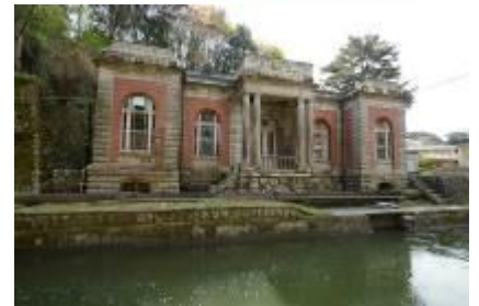
旧御所水道ポンプ室と琵琶湖疏水
