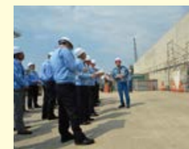
防潮堤建設現場を視察する市町村担当者
