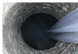
注入孔より挿入
