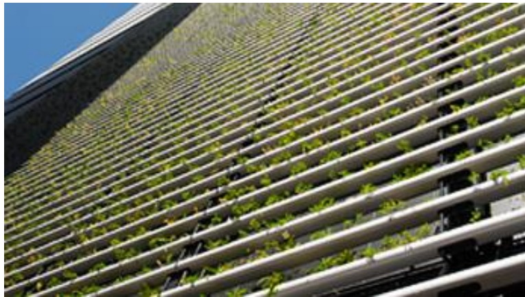
<南壁面に設置した高さ 52m、幅 23.7m、面積約 1,230m 2 の壁面緑化>
