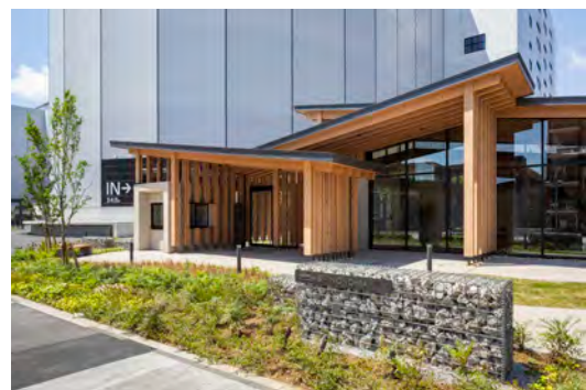
【解体した護岸壁のコンクリートを使用した館銘板】
