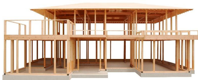
【国産材を使用した柱と梁】
