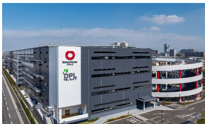
【大和ハウス工業が開発した物流施設「DPL 千葉レールゲート」】
