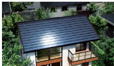
太陽光発電システム
